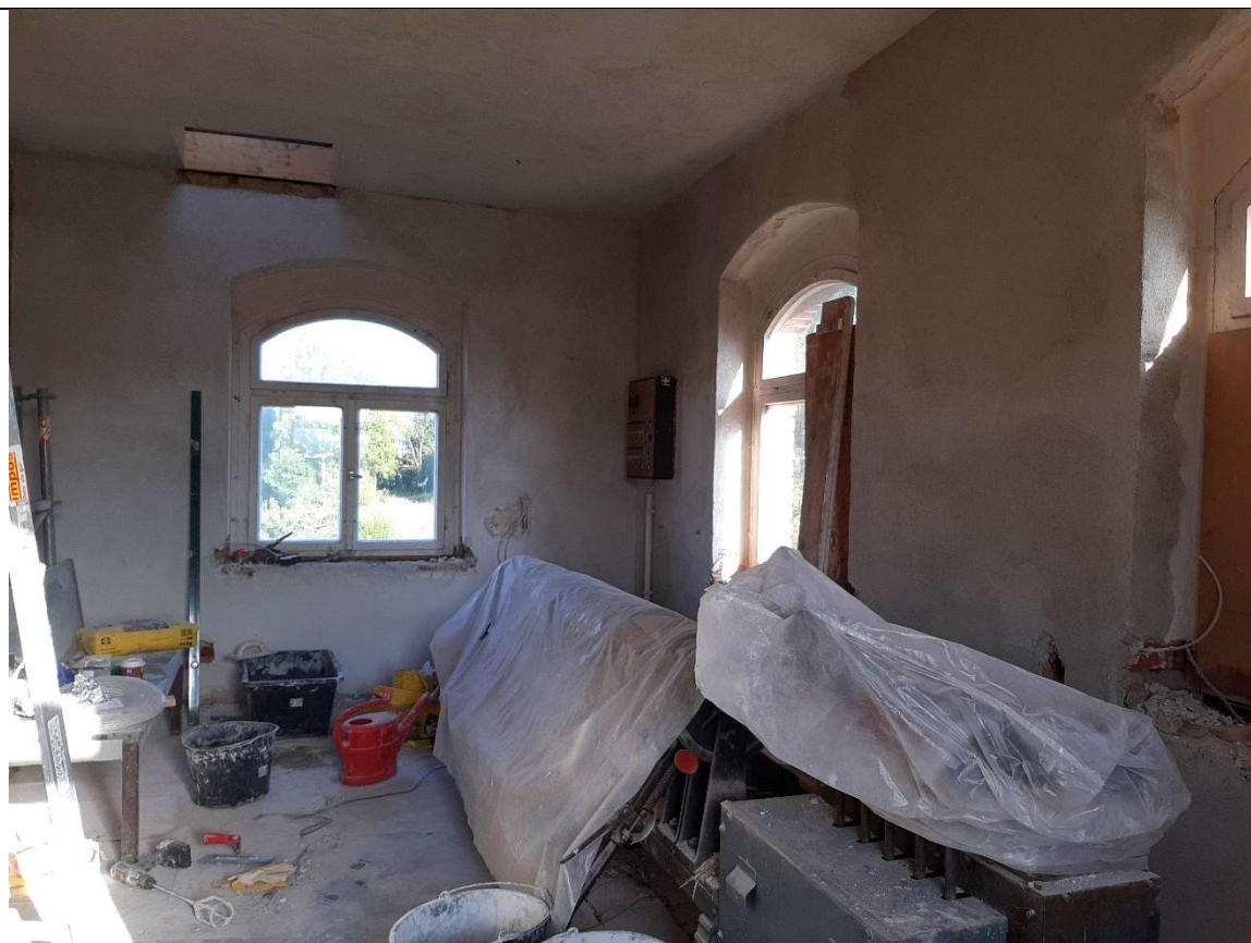
Einige Urlaubstage Anfang August beschleunigten das Verputzen der Wände. (AT)
