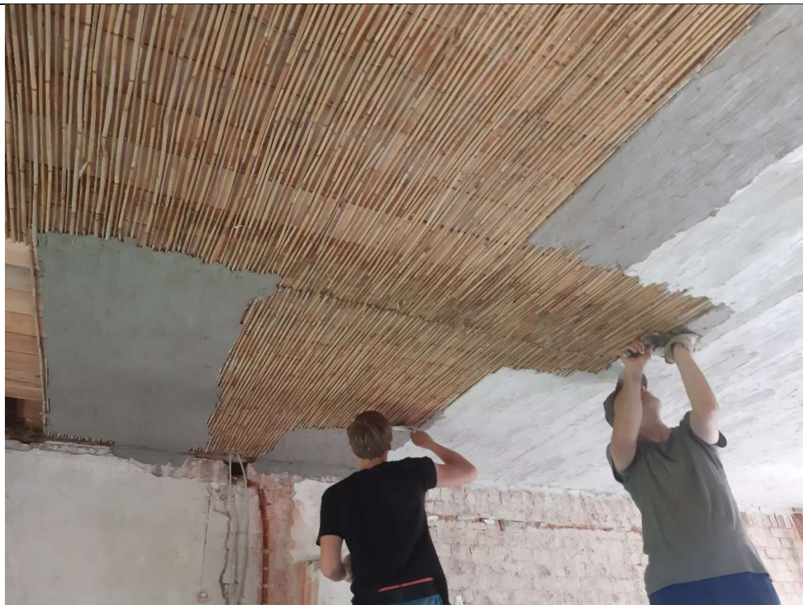
Das Herstellen des Deckenputzes mit Schilfrohrmatte als Träger war sehr aufwendig. (AT)
