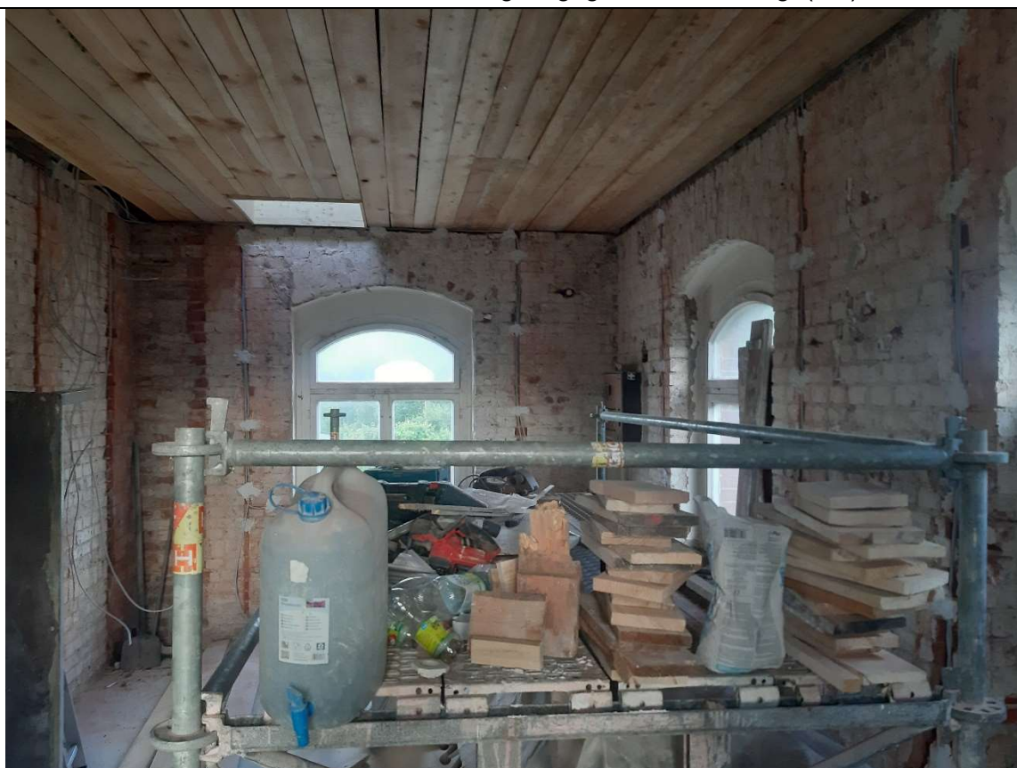
Mitte Juni waren Decke und Wände im Neustädter Stellwerk weitgehend vorbereitet. (AT)
