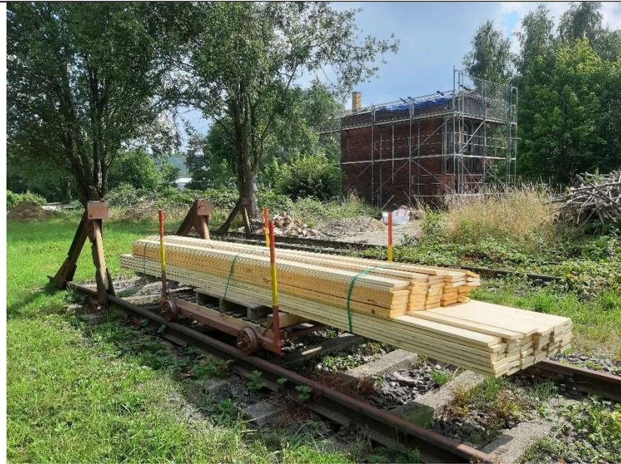
Eine  $\frac{3}{4}$  Tonne Schalung (ca. 55 m<sup>2</sup>) steht zum Einbau bereit. (AT)
