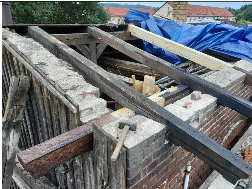
Dort werden sie (und weitere) schrittweise eingepasst... wir versuchen dabei, die originalen Teile soweit wie möglich zu erhalten und traditionelle Verbindungstechniken zu verwenden. (AT)
