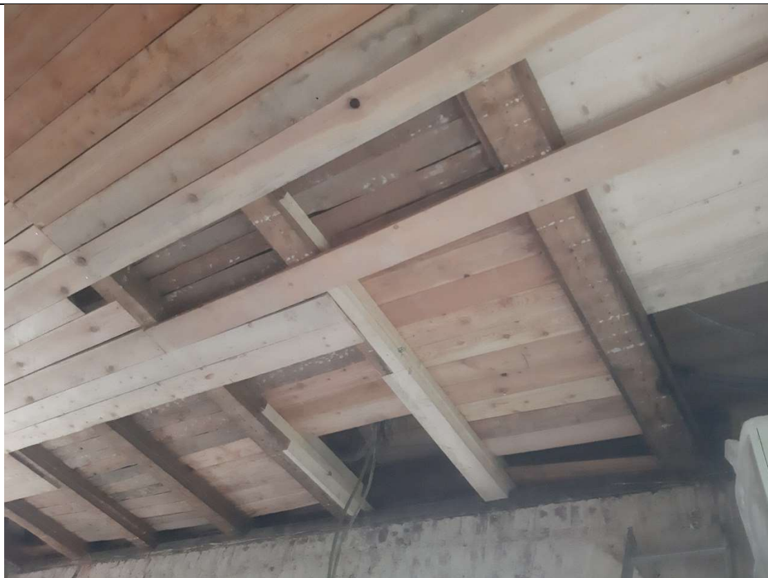
Getauschter Balken und neu Deckenschalung im Neustädter Stellwerk W1. (AT)
