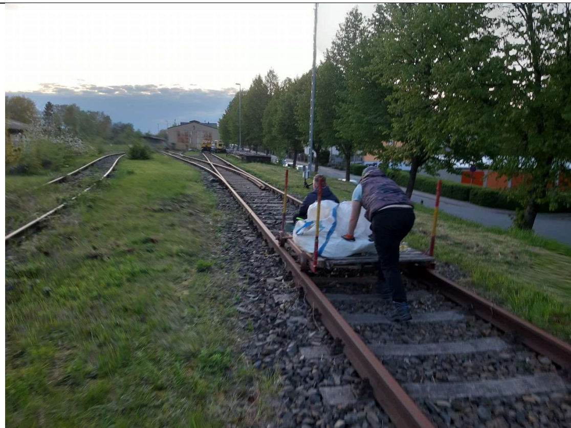
Beräumen der Baustellenabfälle in Neustadt. (AT)
