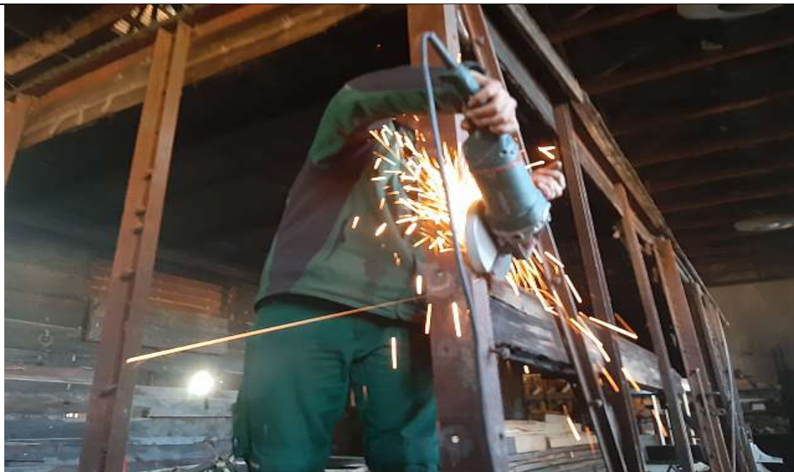
Vorbereitende Arbeiten am Gm der lfd. Nr. 316. (AT)
