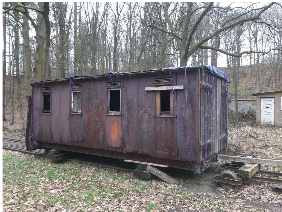
Der 171er in Herrenleite wurde mit einer Plane weiter gesichert. (AT)
