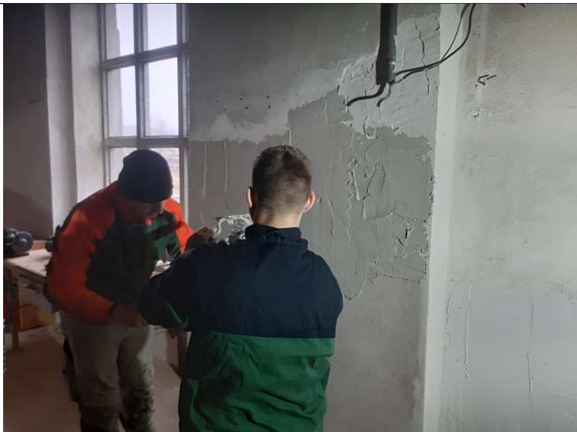
Möglicherweise dank Klimawandel konnten wir bereits im Februar Verputzarbeiten im Lokschuppen fortführen. (AT)
