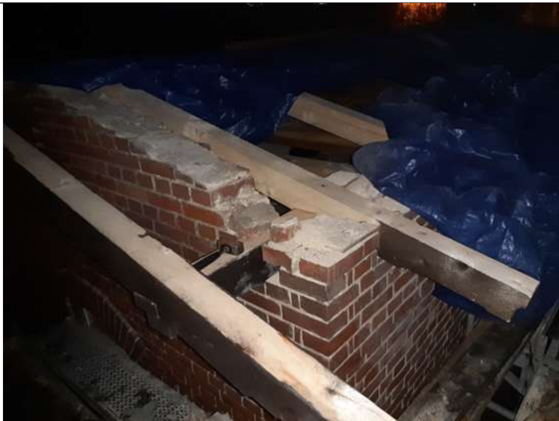
Teils gingen die Arbeiten bis in die einsetzende Dunkelheit. (AT)
