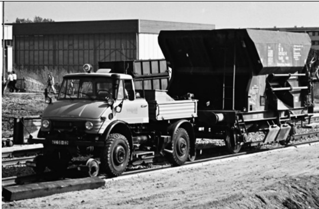
Ein vermutlich etwas jüngerer U406 mit Cottbuser Kennzeichen und Flügelrad beim Gleisbau der Straßenbahnstrecke in Dresden-Gorbitz am 8. September 1984 (Frank Ebermann)
