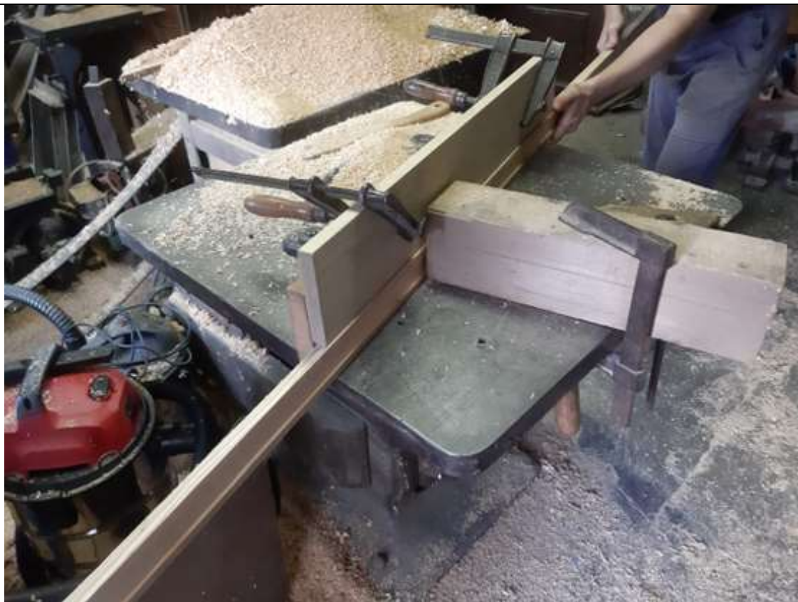
Fräsen der Deckleisten für die Fassadenverkleidung des Stellwerks (AT)
