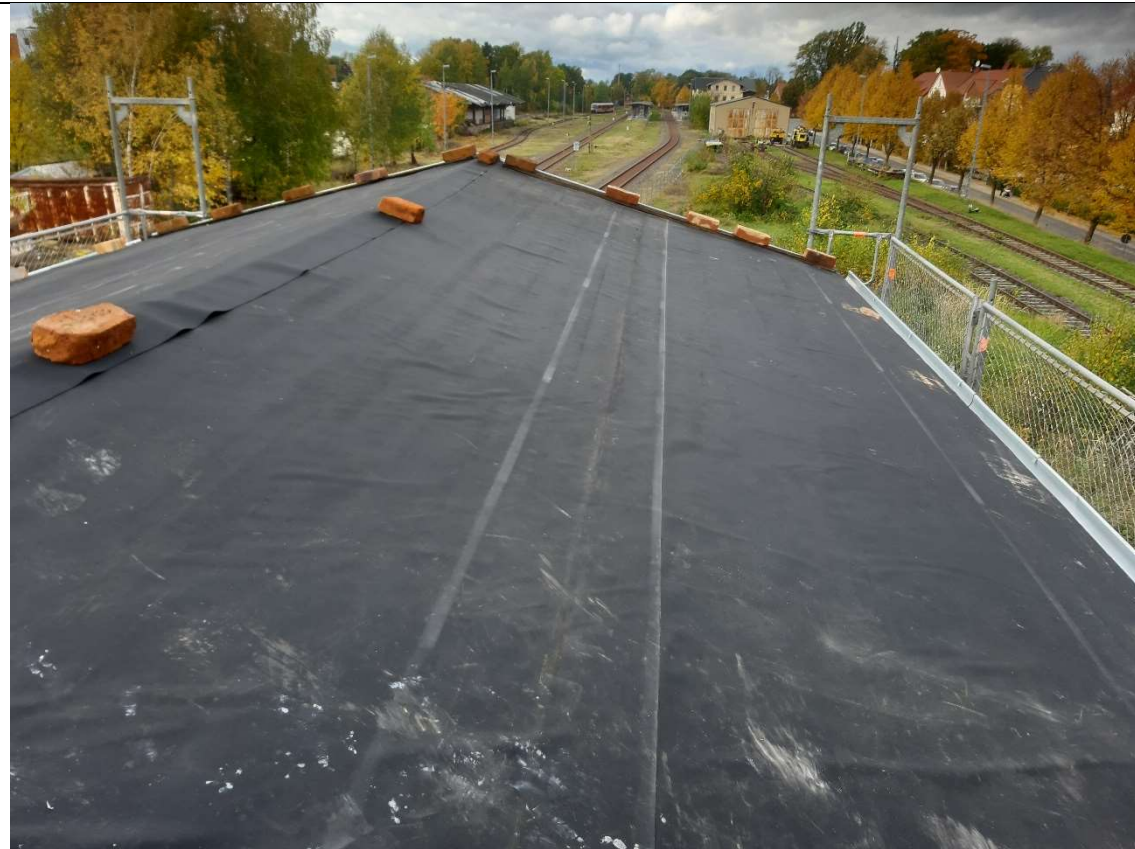
... und Dank Jörg B. und Daniel W. weitere „Kohle“ zu einer Dachhaut aus EPDM. (AT)
