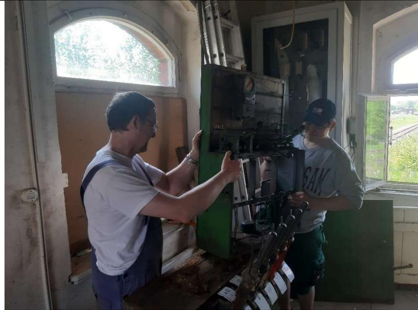
Im inneren wurde der elektromechanische Block vollständig demontiert, um die Aufarbeitung vorzubereiten,
